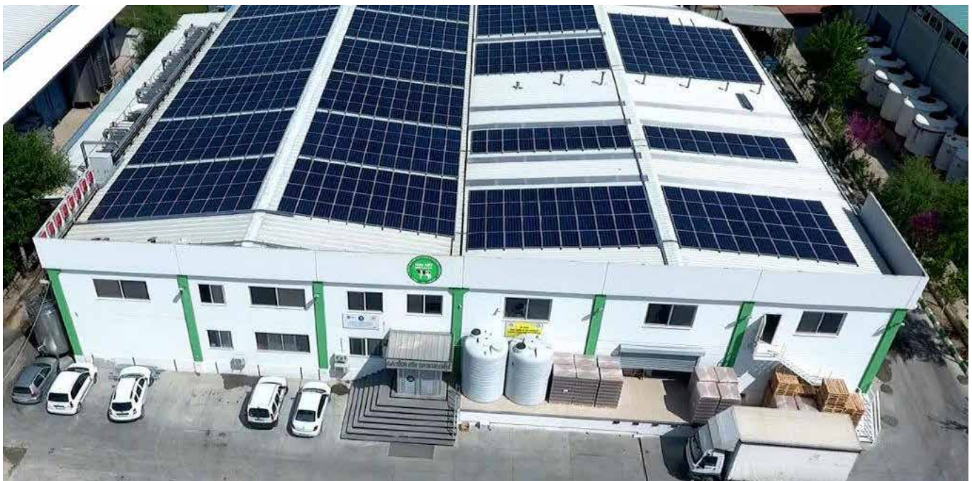
Şekil 91. S.S. Tire Süt Müstahsilleri Tarımsal Kalkınma Kooperatifi Güneş Enerjisi Santrali
