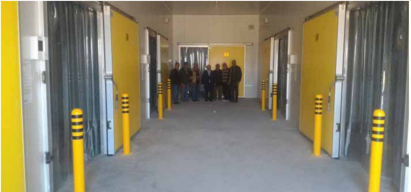
Şekil 87. Kuşçular Köyü Tarımsal Kalkınma Kooperatifi Soğuk Hava Deposu
