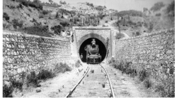
Selçuk - Aziziye (Çamlık) Demiryolu Tüneli TCDD 3. Bölge Müze ve Sanat Galerisi Arşivi
