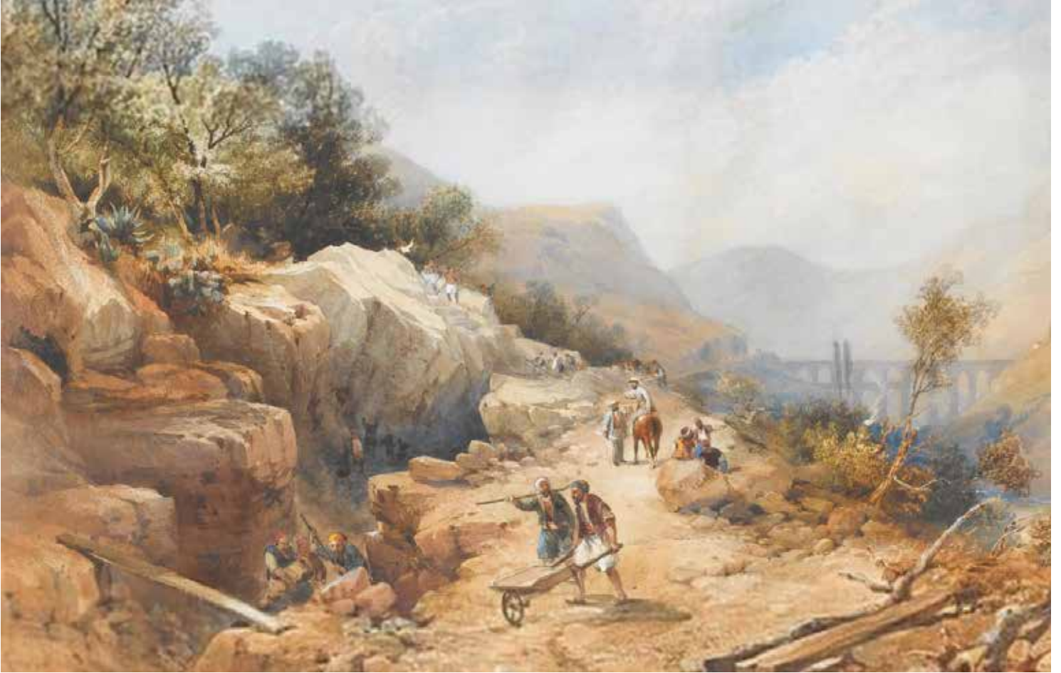
İzmir-Aydın Demiryolu İnşa Çalışmaları, 1860 David Hall McKewan
