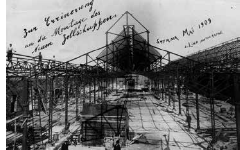
Gümrük Binası ilavelerinin inşası (Yavuz Çorapçıoğlu Arşivi)
