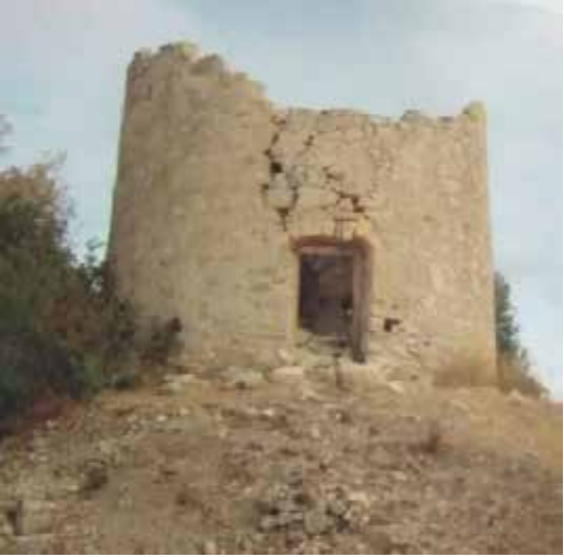
Değirmen Yapısı 1/ Windmill Structure–1
