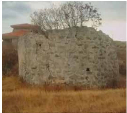
Değirmen Yapısı 5 Windmill Structure–5
