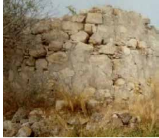
Değirmen Yapısı 4 / Windmill Structure–4
