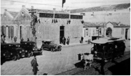
Savaş Atölyesinden eski bir görünüm / Historic View of the Meter Shop (Facebook, 2020c).
