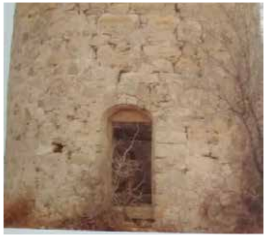
Değirmen Yapısı 6 / Windmill Structure–6
