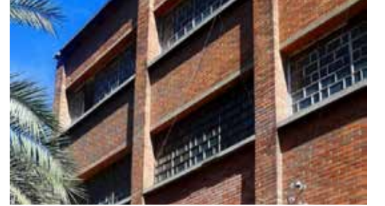
13 Parselde Yer Alan Kuzeydeki Tescilsiz Yapı (Tarkem, 2000)
