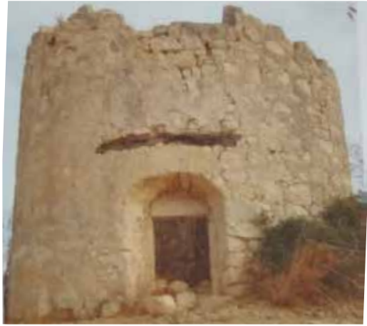
Değirmen Yapısı 3 / Windmill Structure–1
