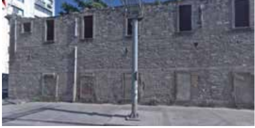
Depo Yapısının Günümüzdeki 1267 Sokak
