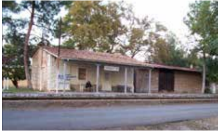
Arıkbaşı Yerleşkesi / Arıkbaşı Compound (Ekizoğlu, 2012)
