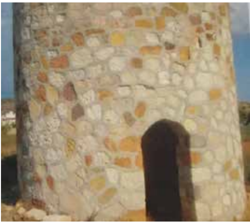
Değirmen Yapısı 7 / Windmill Structure–7
