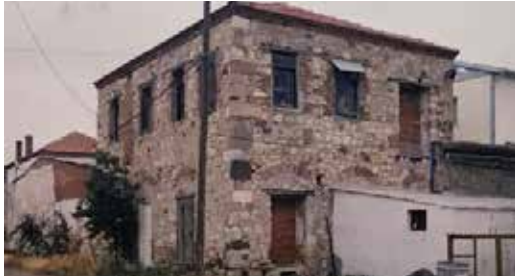
Aliaga Yenişakran Fabrika Yapısı (İzmir 2 No.lu KVKBK Arşivi) /Aliaga Yenişakran Factory Structure (İzmir RCC–2 Archive)
