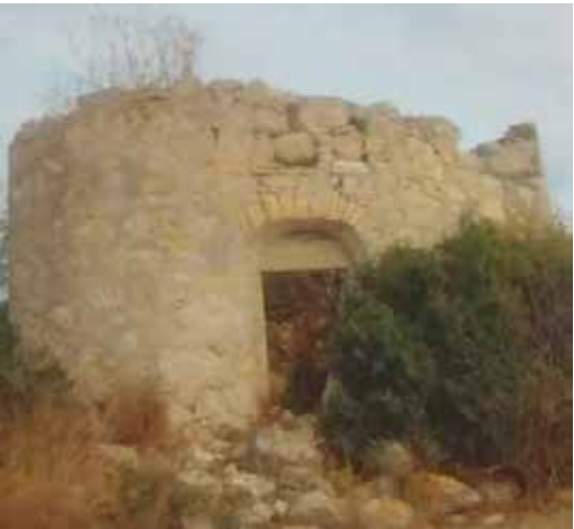
Değirmen Yapısı 2 / Windmill Structure–2
