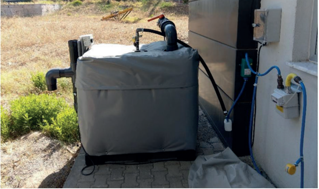
Şekil 48. TEMSAN ve Ege Üniversitesi BESTMER arasında imzalanan sözleşme kapsamında denemeleri gerçekleştirilen reaktör
